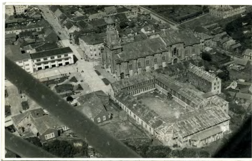
IMAGEN 30. Vista aérea del Seminario y su gimnasio, 1960. CEC-MRA.
